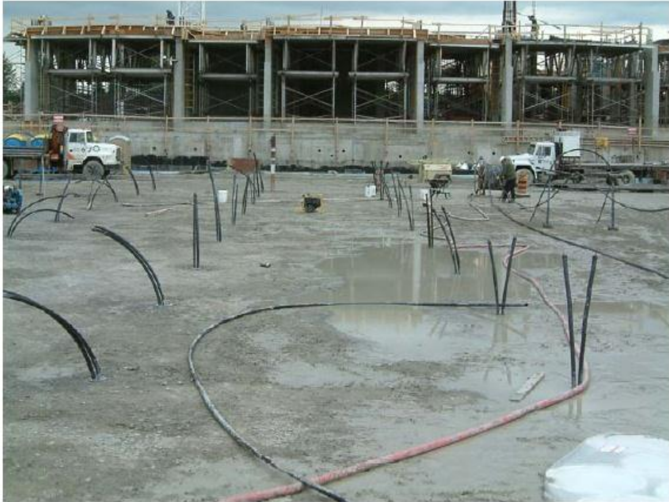
Şekil 5. Kuyu içi ısı deđiřtiricilerinin yerleřimi (Eksenler arası: 4.5 m)
